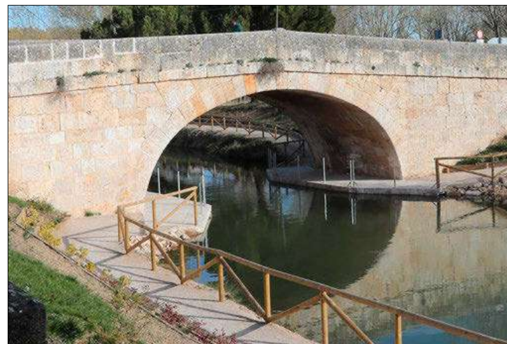
Resultado de las obras del Canal de Castilla en una imagen de archivo. ICAL
