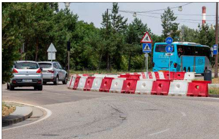
Imagen del tramo cortado por el hundimiento. TOMÁS ALONSO
