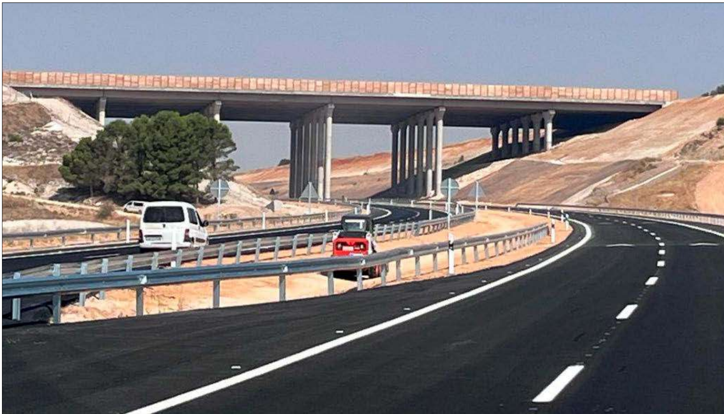
Tramo de la autovía A-11 en la provincia de Valladolid, a la espera de su apertura provisional. E. M.
